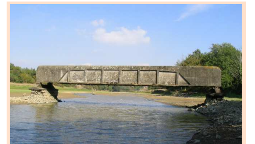
Le pont « Boche », qui enjambe l'Yon, constitue le seul vestige industriel des mines de la Thermelière. Ouvrage préfabriqué en béton armé, il permettait d'acheminer les wagonnets chargés de minerai vers La Roche-sur-Yon. Le minerai était dirigé par voie ferrée jusqu'aux Sables-d'Olonne, puis expédié jusqu'en Allemagne.
