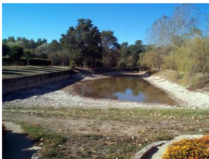
Exutoire de la nappe du Dogger au "Port d'Aziré" à Benet en période d'étiage intense
