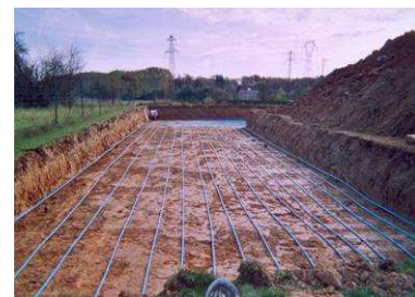
Capteur horizontal disposé en déchapeage
