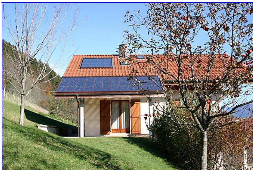
Logement avec chauffe-eau solaire et toiture photovoltaïque raccordée au réseau électrique (Crédit Clipsol)
