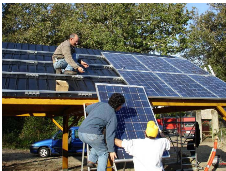
Installation photovoltaïque de 3 kWc en cours d'installation (crédit JPL)
