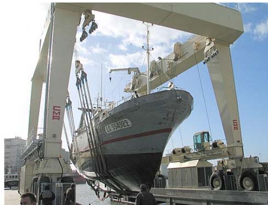
Construction d'un élévateur à bateaux pour le port des Sables-d'Olonne.
