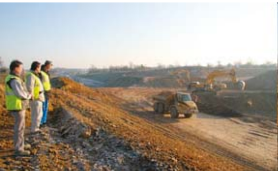
Réalisation de contournements routiers
